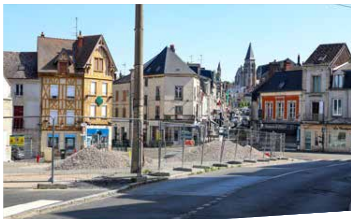
TRAVAUX EN COURS
